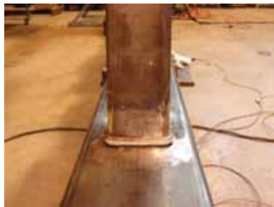
(d) T-0.50-34: chord face rupture
