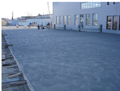
(d) Concrete placement.
