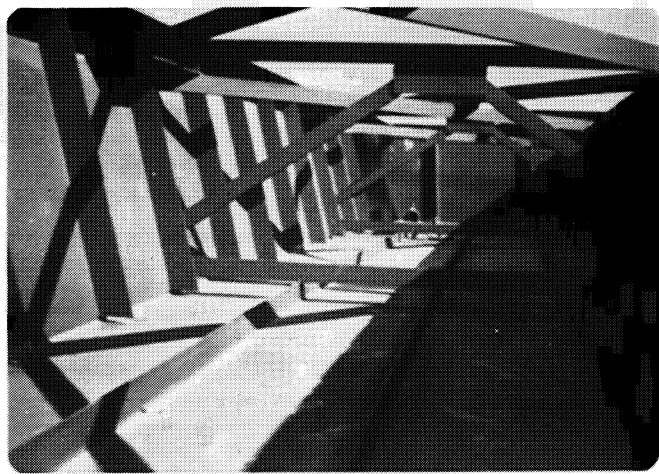
Fig. 20. Internal diaphragms
